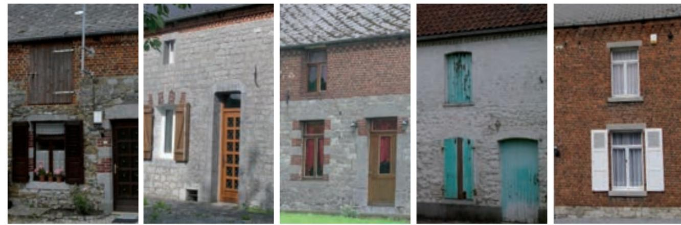
Surélévation en brique sur un rez-de-chaussée en maçonnerie composite.
