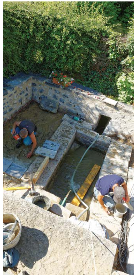
Rénovation de la fontaine de la rue La Haut à Dourlers - Photo : Samuel Dhote
