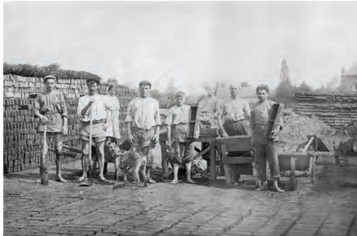
Briqueterie typique. On aperçoit sur le devant de la photographie les briques posées au sol entraîné de sécher. Au second plan, un chien utilisé pour tirer les traîneaux chargés de briques est posté devant les hommes responsables de la préparation de l'argile et un jeune enfant portant un moule à briques. À gauche, les briques empilées sous un lit de branches sont prêtes à cuire (Martine Houze, « Objets, lieux et Coutumes dans l'Avesnois rural » Edit. SERG p36-37)
