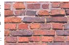
Maçonnerie de briques du XV e siècle
