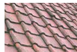
Toiture en tuiles anciennes de terre cuite
