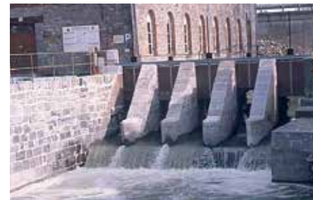
Restauration des ventelleries d'Etroeungt
