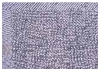
Pierre de remplacement layée et bouchardée
