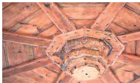
Charpente du kiosque - Sars Poteries
