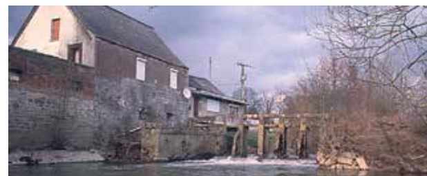
Ventelles attenantes à l'ancien moulin de Boulogne sur Helpe - Lecture des éléments manquants
