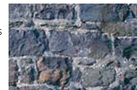
Maçonnerie de moellons de pierre
