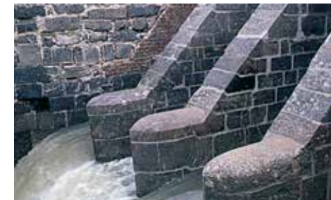
Les éléments remplacés respectent l'édifice d'origine
