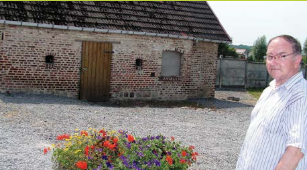
Jacky Duminy, Maire d'Ors, à l'initiative du premier micro réseau de chaleur communal en Avesnois.
