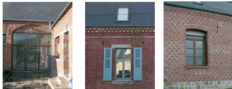
Porte de grange transformée en baie vitrée. Châssis de toit encastré composant avec la baie existante. Menuiserie restaurée et volets roulants intégrés.
