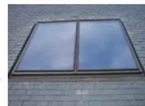
Panneau solaire thermique intégré à la toiture
