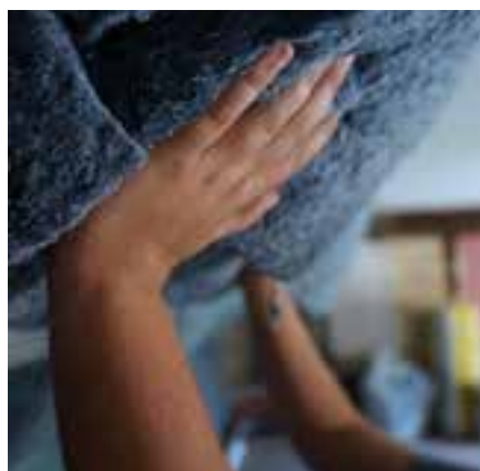
Pose de mêtisse (matériau bio-sourcé)
