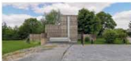
La chaufferie bois déchiqueté
