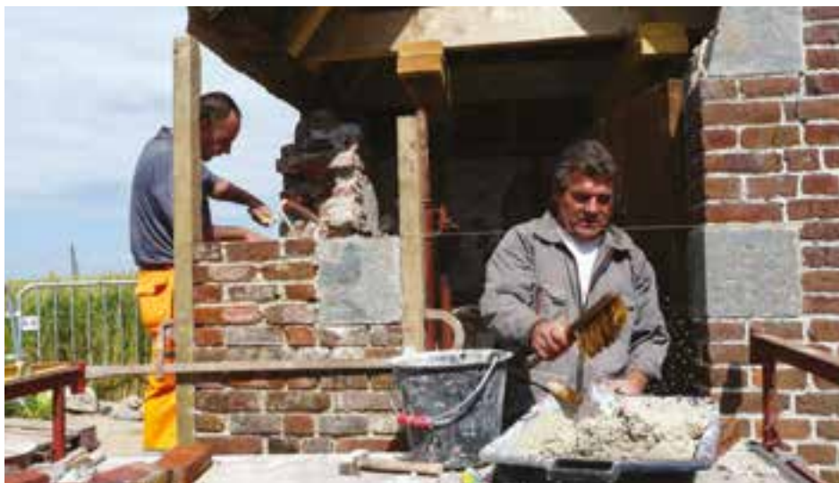
Chapelle de la Tourelle à Hon-Hergies- chantier de restauration projet Interreg
