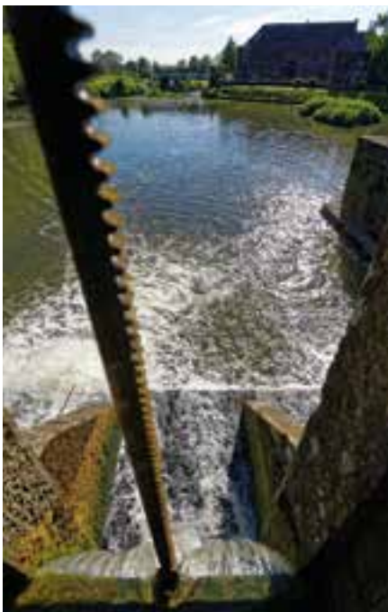
Vue du gouffre de Marolles depuis le vannage.
