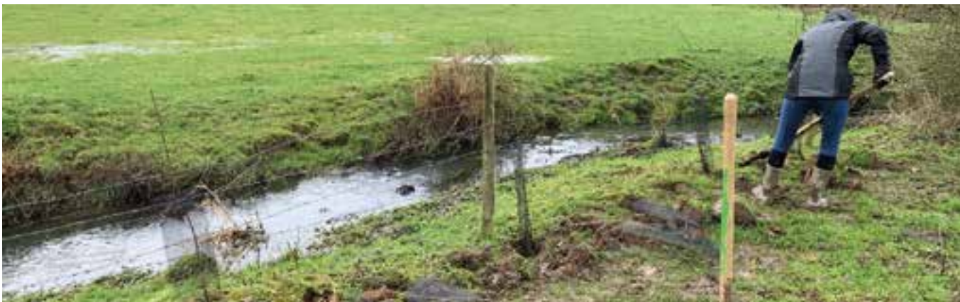
Chantier de plantations
