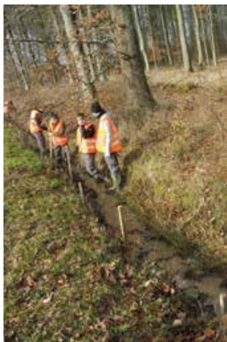
Mise en place du batrachoduc à Locquignol (RD32)
