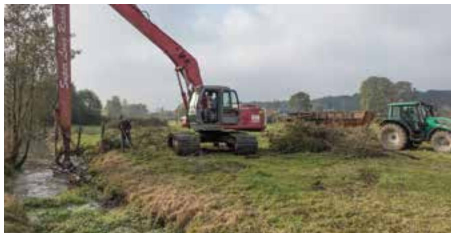
Chantier d'arrachage de l'Hydrocotyle fausse renoncule à Ors
