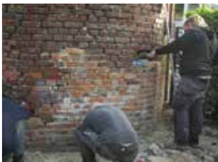
Chapelle Notre Dame des Affligés à Louvignies Quesnoy/Chantier de restauration - projet Leader
