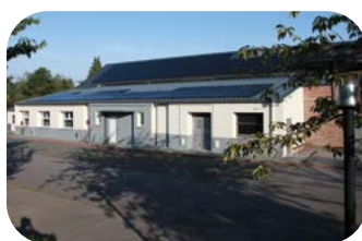
Équipement public à Anor : centrale photovoltaïque citoyenne de 36 kWc en revente totale.
