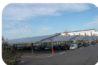
Ombrière sur parking, site de Maubeuge Construction Automobile (48 000 panneaux photovoltaïques - 7,9 ha), Maubeuge
