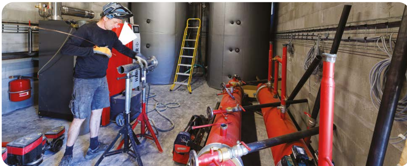
Installation d'une chaufferie au bois-énergie
