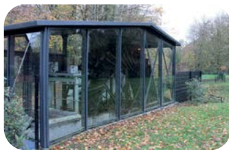
Site après les travaux
