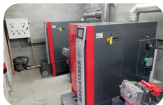
Chaudières dites en cascade de la chaufferie de Wallers-en-Fagne
