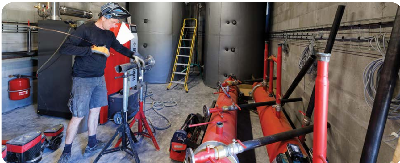
Installation d'une chaufferie au bois-énergie
