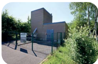
Chaufferie à Anor alimentant 5 bâtiments et 2 logements
